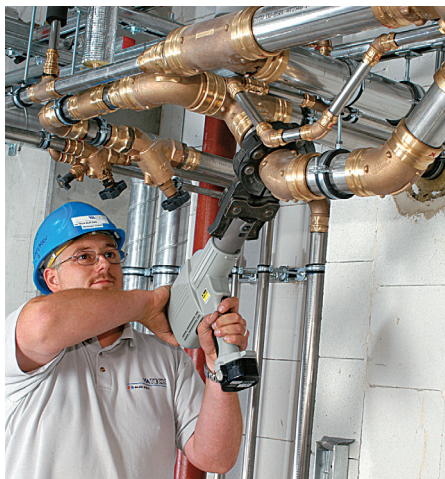
Présgyűrűs préselés a szűk, nehezen hozzáférhető helyeken, már kis átmérőknél is
