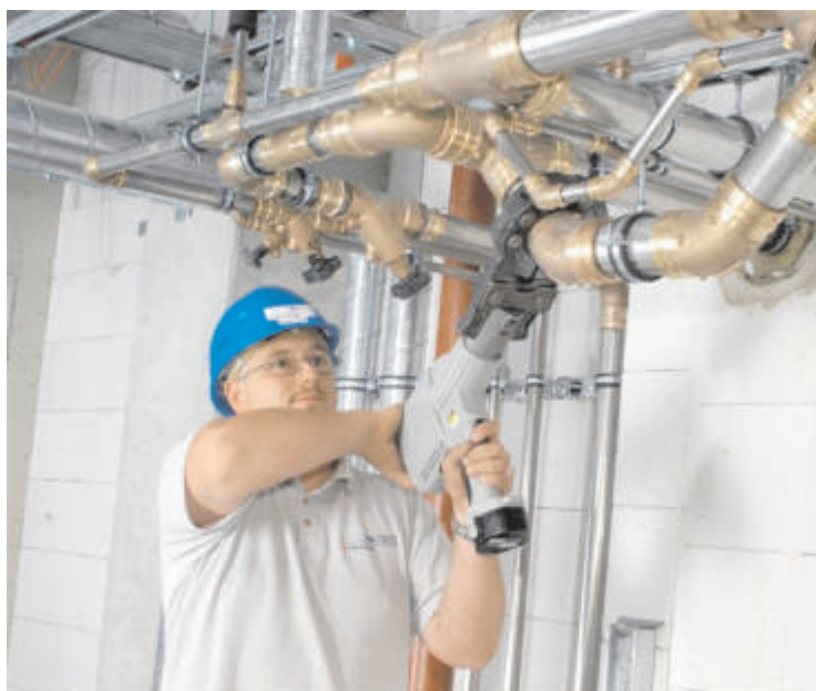
2. ábra: Présgyűrűs préselés a szűk, nehezen hozzáférhető helyeken, már kis átmérőknél is
