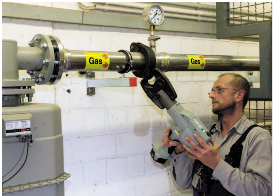
A mobil Viega akkumulátoros prészserszám munka közben: egyetlen szerelő által elvégezhető gazdaságos munka, présfával és présgyűrűvel, tűzveszély kizárt.
