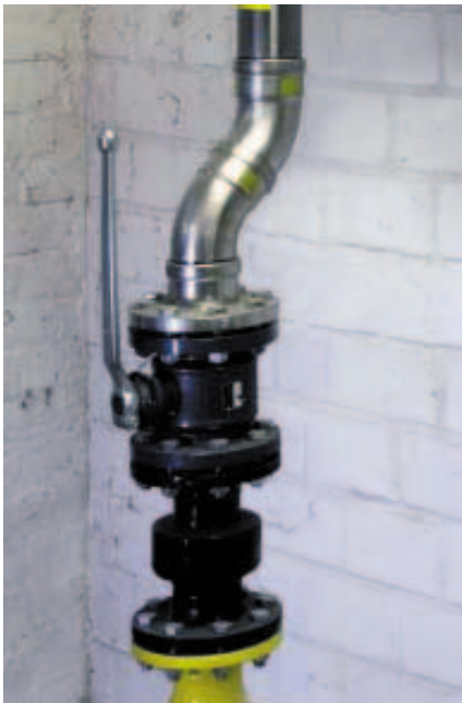
Átmenet Sanpress Inox G karimákkal, SC-Contur-ral (biztonsági kontúr).
